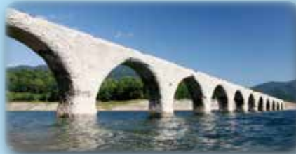
タウシュベツ川橋梁
